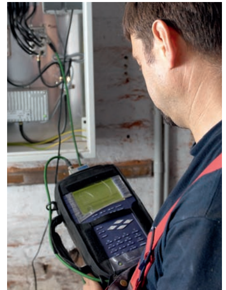
Mit dem so genannten Wobbler kann Servicetechniker André Goldberg die Signalstärken für Internet und Telefonie messen
